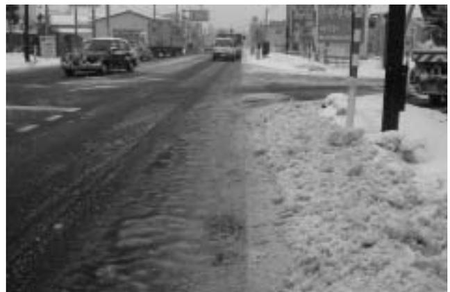
写真-8 普通アスコン部の圧雪状況(下り線)
