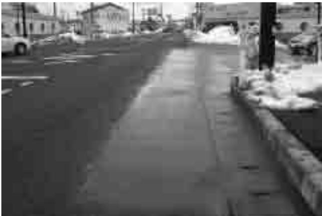
写真-7 凍結抑制舗装の完成状況(上り線)
