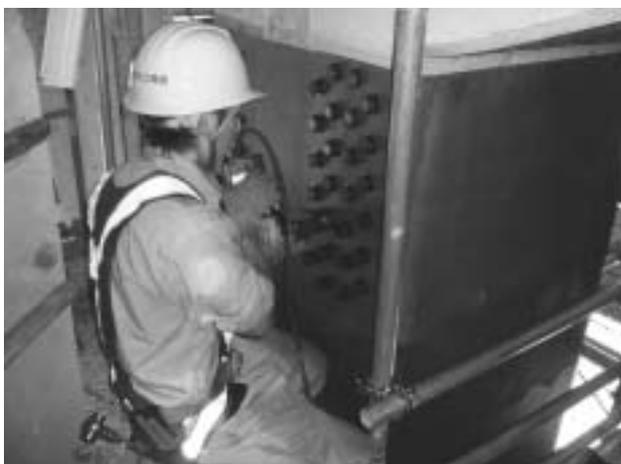
写真-4 頂部波形分割鋼板組立て状況
