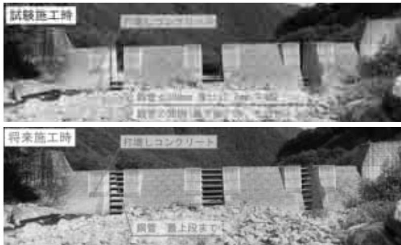
写真-1 扇沢砂防えん堤シャッター設置時のイメージ（フォトモンタージュによる）
