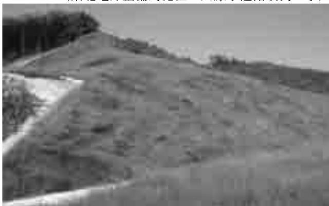
写真・6 厚層基材吹付け工 (施工後 6 ヶ月)
