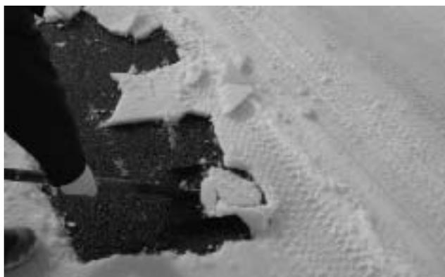
写真-4 圧雪の剥がれ状況（1シーズン目）
