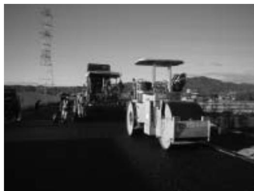
写真-2 施工状況(高機能舗装下層)
