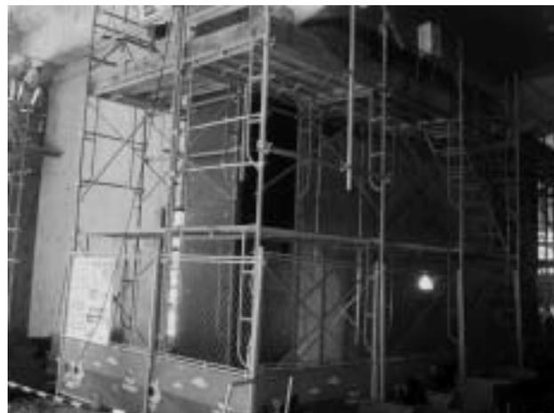
写真-5 波形分割鋼板組立て完了
