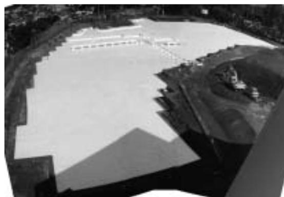
図－10 EPS施工状況
