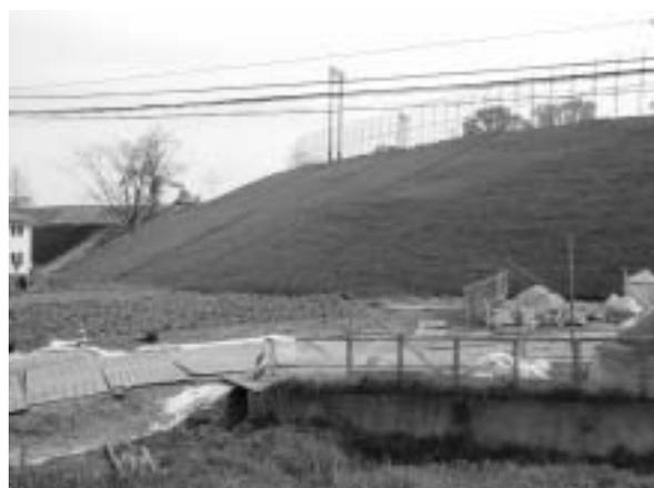
図-1-2 上層施工状況（厚層基材発芽状況）
