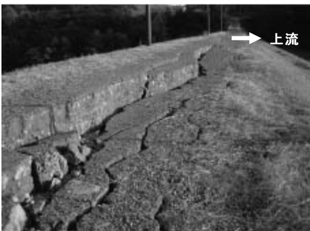
写真-1 被災後の堤頂部の状況
