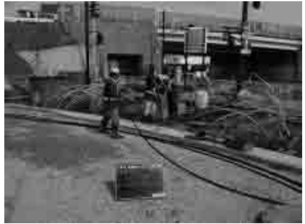
写真－2 ヒートパイプ挿入作業
