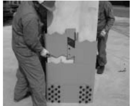
写真－1 波形分割鋼板組立て状況
