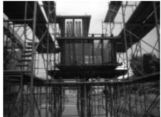
写真-1 実物大模型試験打設
