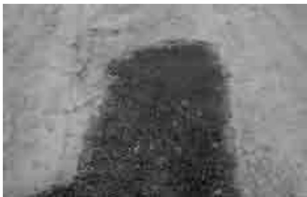
写真-5 圧雪の剥がれ状況（2シーズン目）
