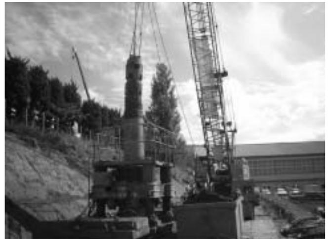
図－8 抑止杭掘削状況
