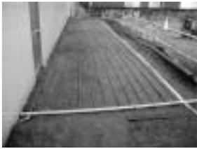
写真-3 放熱管設置状況
