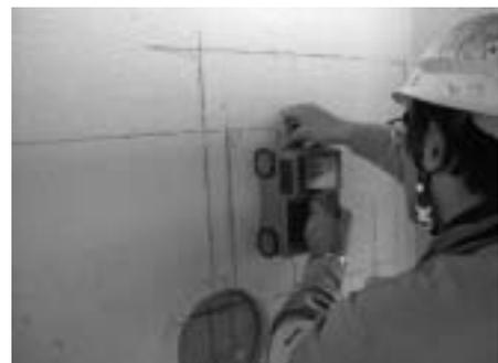
写真-2 鉄筋探査状況
