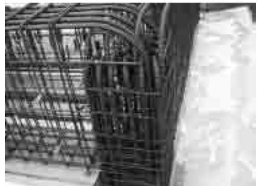
写真-2 柱・梁接合部の過密配筋状況
