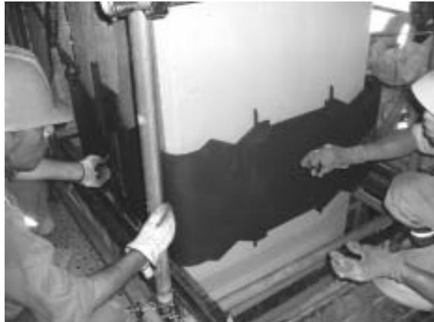
写真-3 標準部波形分割鋼板組立て状況
