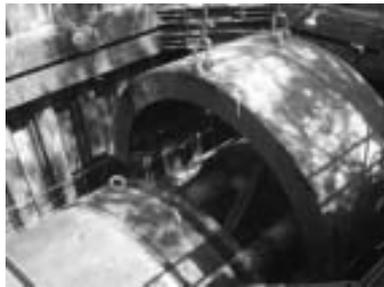
写真-3 外殻上部撤去(到達立坑)
