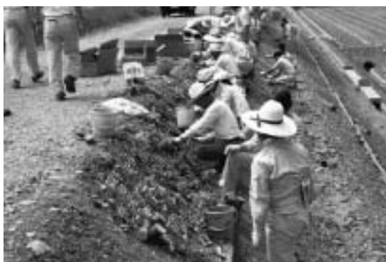
写真-1 人力によるGCPの植栽状況
