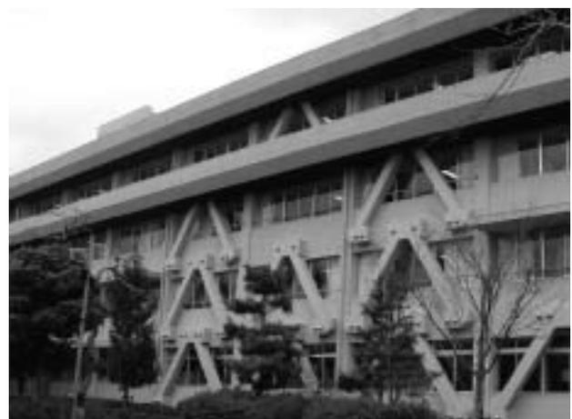
写真-1 ブレース取付け外観（例）
