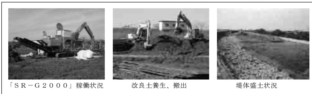
写真－9 改良工事施工状況
