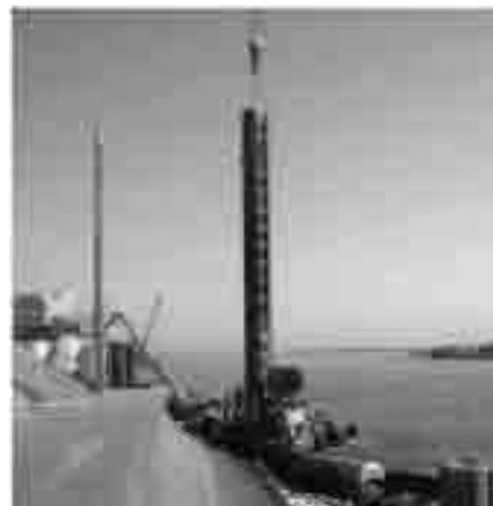
施工－2 鋼管建込み状況
