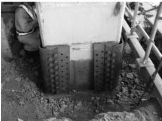
写真-2 基部波形分割鋼板組立て状況
