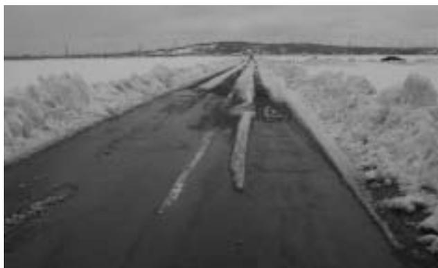
写真-3 機械除雪後の圧雪の剥がれ状況
