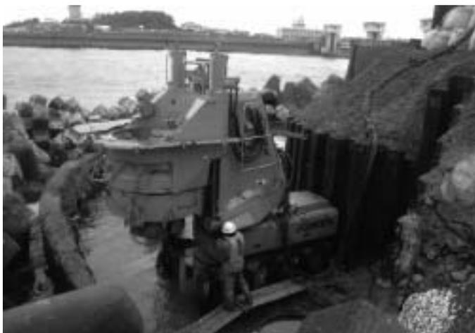
施工－1 鋼管パイラー組立状況
