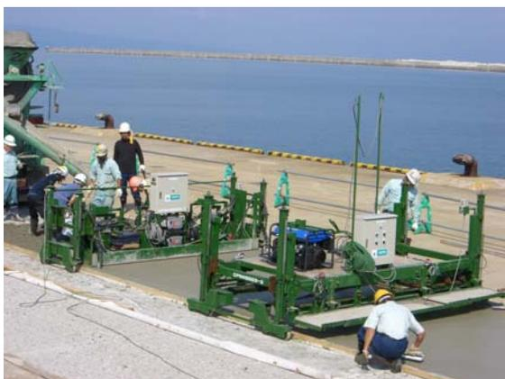
写真-3.1 SFRCオーバーレイ施工状況
