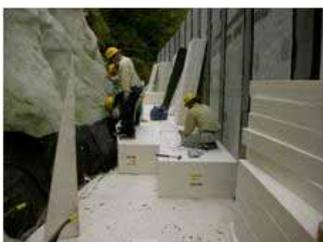
写真 - 10 EPS施工状況
