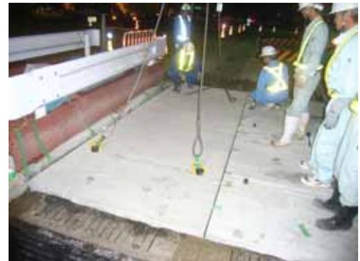
写真-6 復旧箇所のPRC版設置状況
