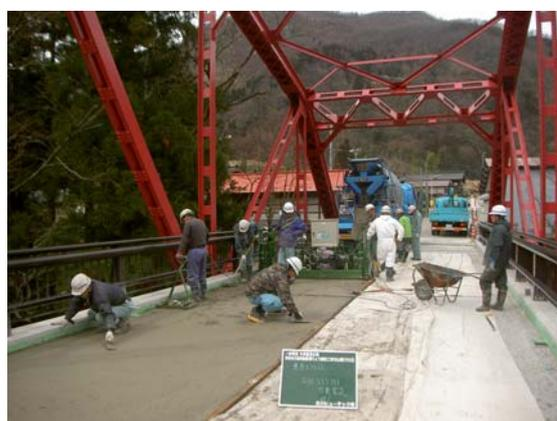
写真-3.2 床版増厚施工状況
