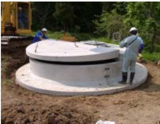
写真 - 1 集水井天蓋掛替え工事状況
