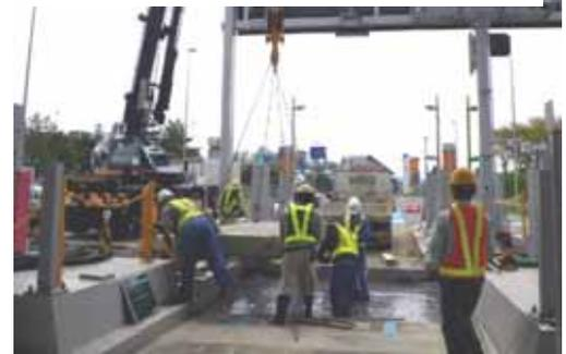
写真-7 ガントリーをかわした設置状況
