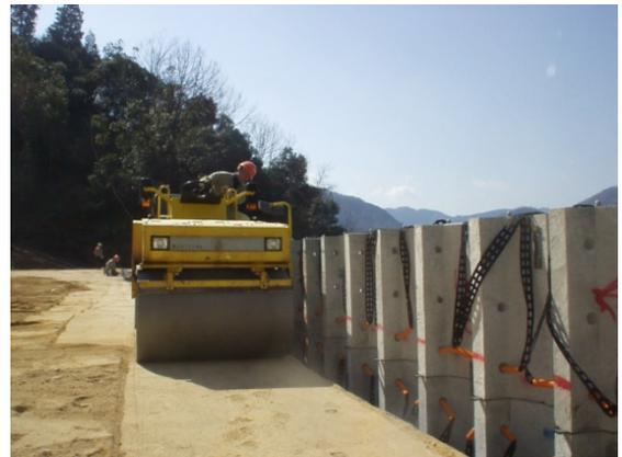
写真－2 重機による壁面近傍締固め状況
