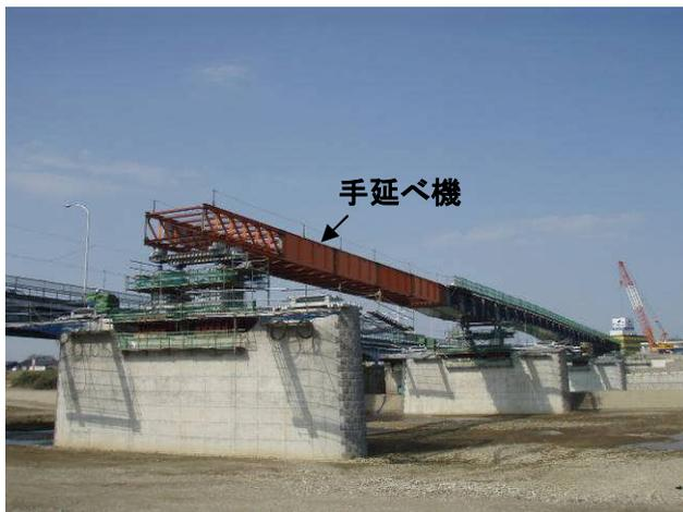
写真-3 G2桁送り出し架設状況
