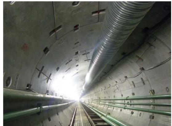
写真-4 都水道局：東南幹線セグメント組立て状況
