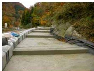
写真 - 11 保護コンクリート完了
