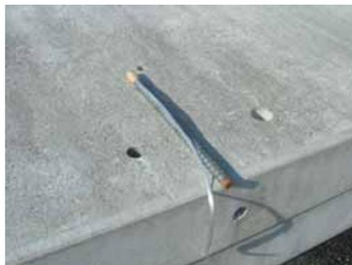
写真-1 連結鉄筋の準備状況
