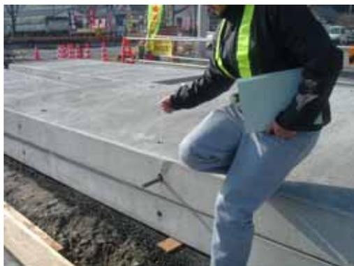
写真-2 連結鉄筋の挿入方法
