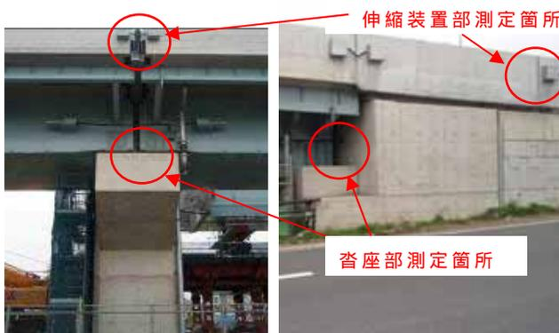
写真-3 振動測定箇所
