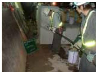
写真 - 6 横締PC鋼材挿入状況
