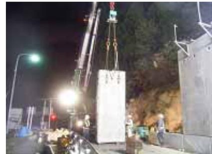
写真 - 4 側壁架設状況
