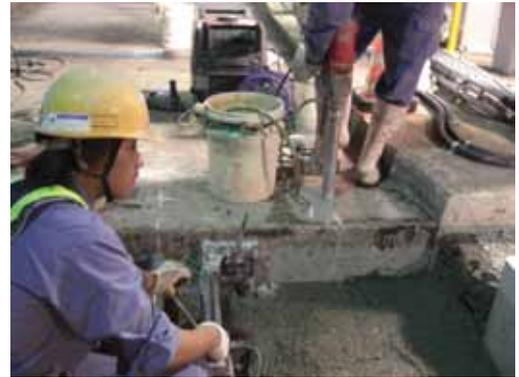
写真-5 既設コンクリート版の削孔状況
