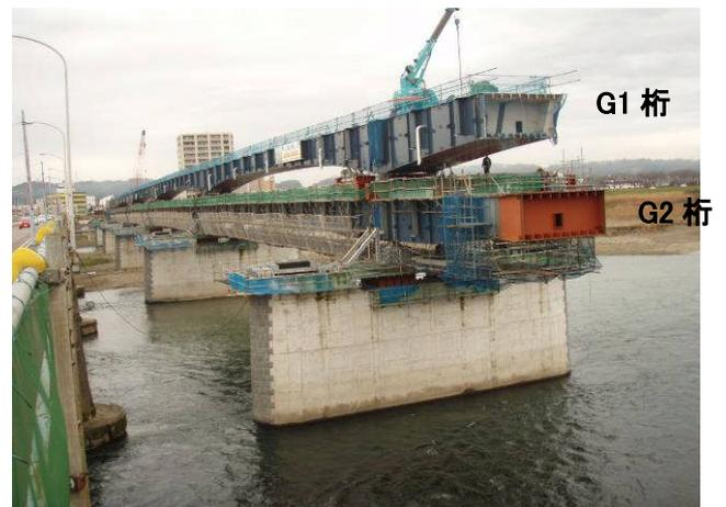
写真-4 G1桁の送り出し架設状況
