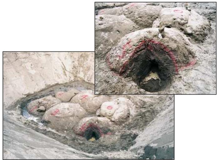
写真-1 掘削により確認されたシェル型改良体
