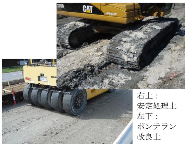
図-8 締固め特性とオーバーコンパクション
