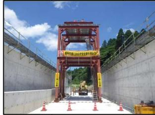
写真-3 架設用支保工
