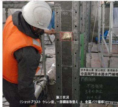
写真-10 施工状況(門柱補修)
