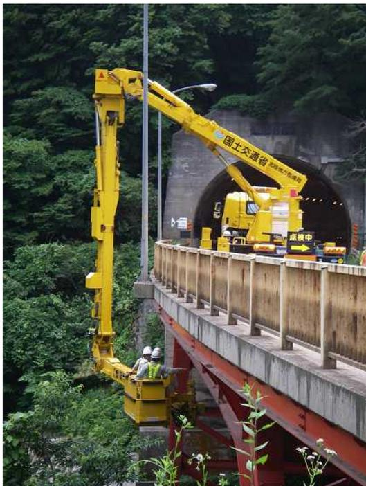
図-5 橋梁点検車を使った点検
