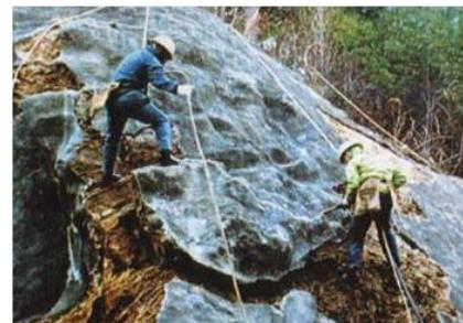
写真-1 吹付材のはつり取り作業
