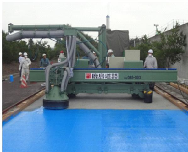
写真-4 試験施工における塗布状況
