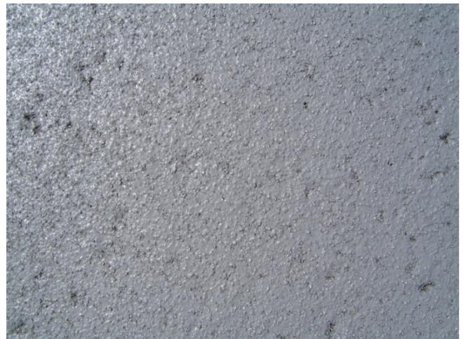
写真-3 遮熱性舗装 施工直後
