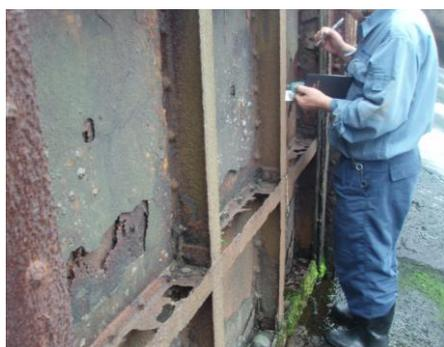
写真-6 下流側より扉体を近視 (鋼材の断面欠損→取替必要)
