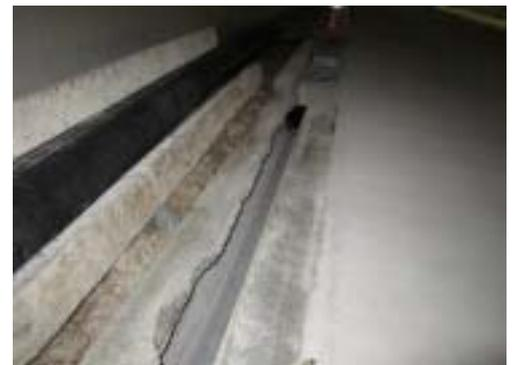
(写真 - 2) 側溝水路部破損例
