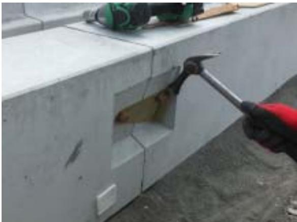
(写真 - 5) 連結プレート打込み状況
