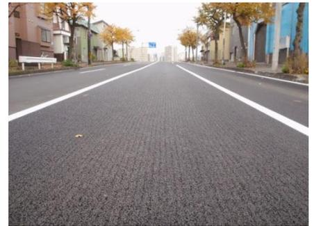
写真-2 施工直後の路面状況
