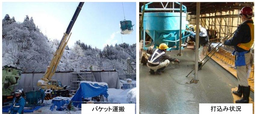
写真-1 サクセムの打込み状況
