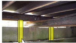
・H鋼の腐食が進行し、一部歪曲している鋼材もある。
