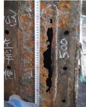
写真-8 門柱を近視 (孔食が進行→補強必要)
