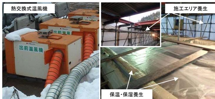
写真-4 給熱養生状況
