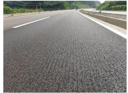
写真-1 縦溝粗面仕上げの例
