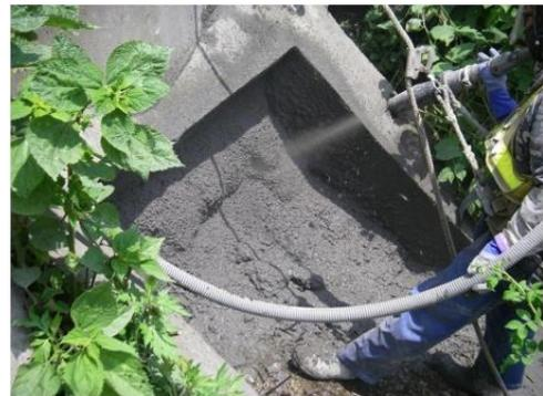
写真-3 吹付状況(法枠は既往施工済)
