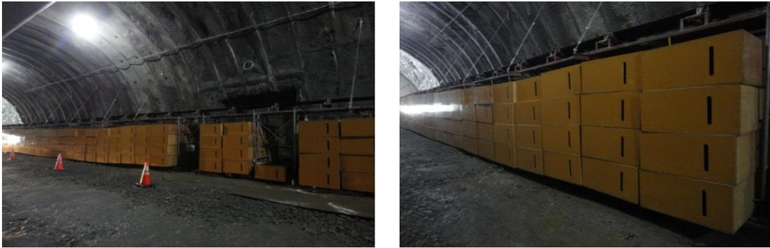
写真－1 吸音ボックス設置状況（吉浜トンネル）
