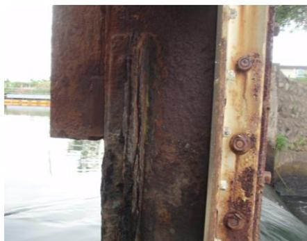
写真-7 側面より戸当りを近視 (鋼材の断面欠損→取替必要)
