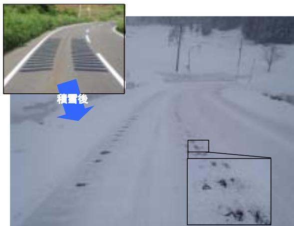
写真-4 ファインシートの凍結抑制効果
