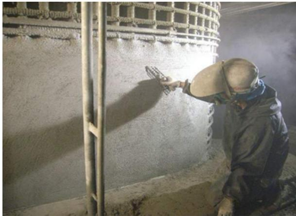
写真-4 乾式吹付仕上げ状況
