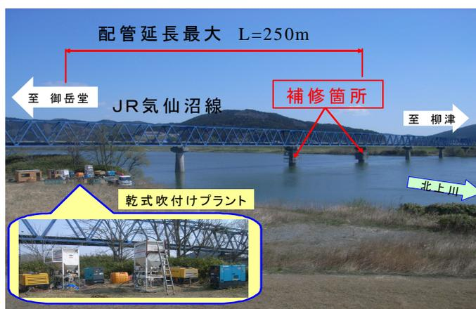
写真-2 乾式吹付施工状況
