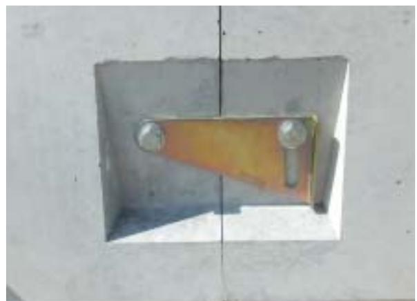
(写真 - 6) 連結プレート設置完了状況
