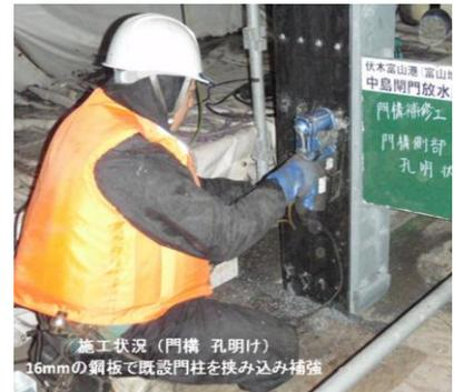
写真-11 施工状況(門柱補強)
