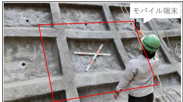
図－2 モバイル端末を用いた地上写真測量の作業状況
