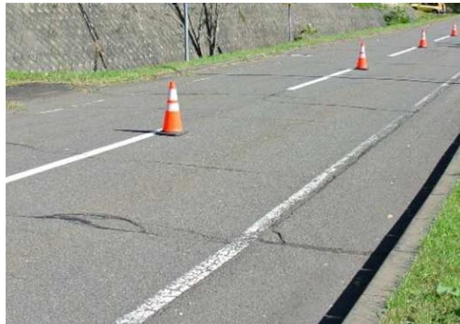
写真-1 温度応力ひび割れ
