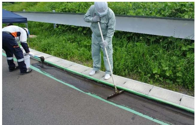
写真-2 施工状況（レベリング材の塗布）
