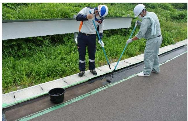
写真-3 施工状況（トップコートの塗布）
