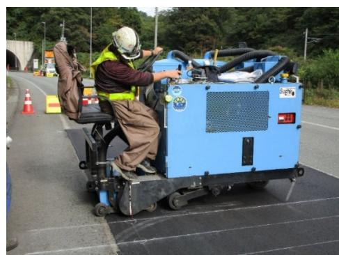
写真-2 音響グルービング切削状況
