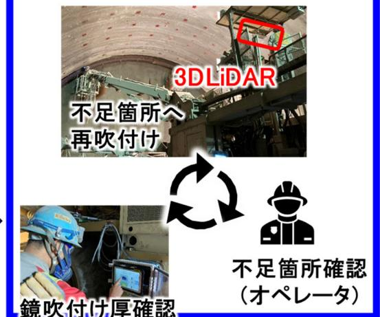
図-8 最適鏡吹付け厚決定システムと鏡吹付け厚管理システムを活用した鏡吹付け管理システムのフロー
