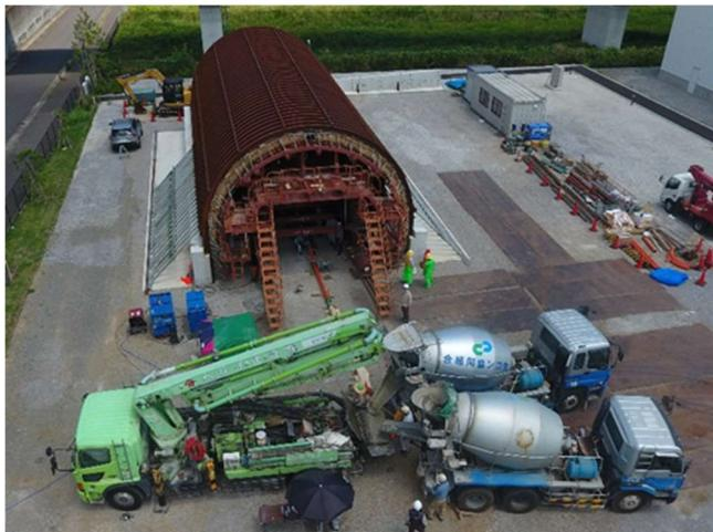
写真-1 覆工実物大施工実験の実施状況
