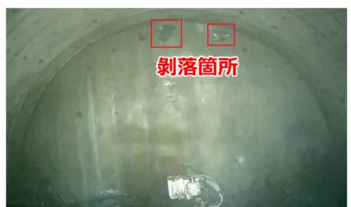
図-7 切羽監視カメラによる剥落の確認
