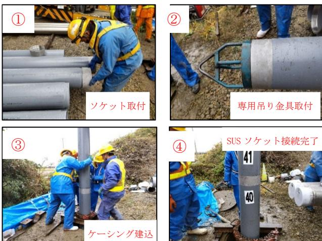
写真 4 SUS ソケット取付状況
