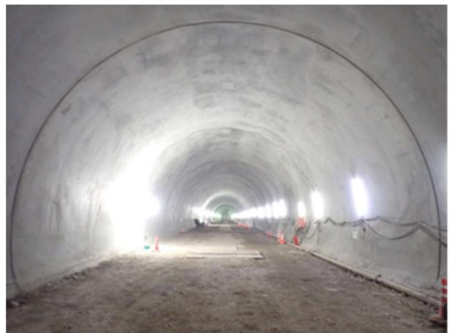
写真－2 本システムを適用したトンネルにおける覆工の出来映え
