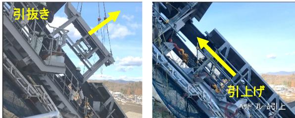
写真-2 フレーム引抜き、引上げ
