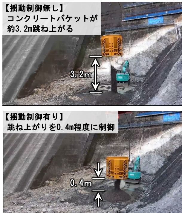
図－5 放出時における揺動制御有無の比較
