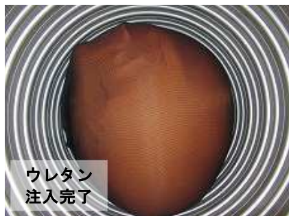
写真-7 ウレタン注入完了状況
