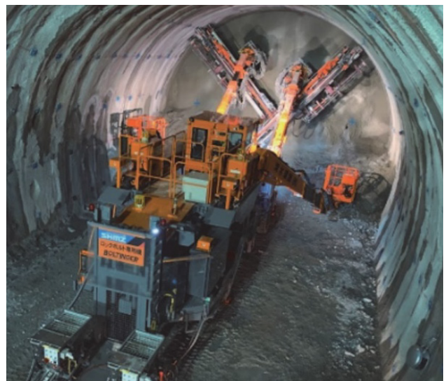
写真－３ 2ブームロックボルト打設専用機
