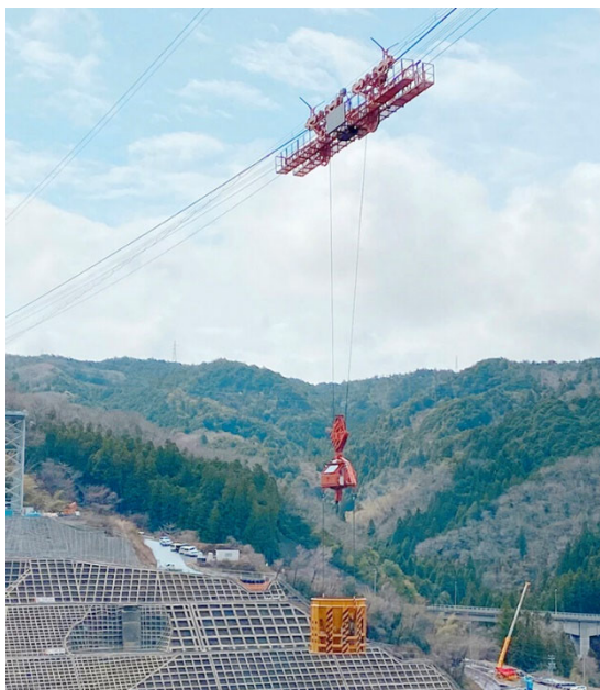
写真－１ ケーブルクレーンによるコンクリート運搬
