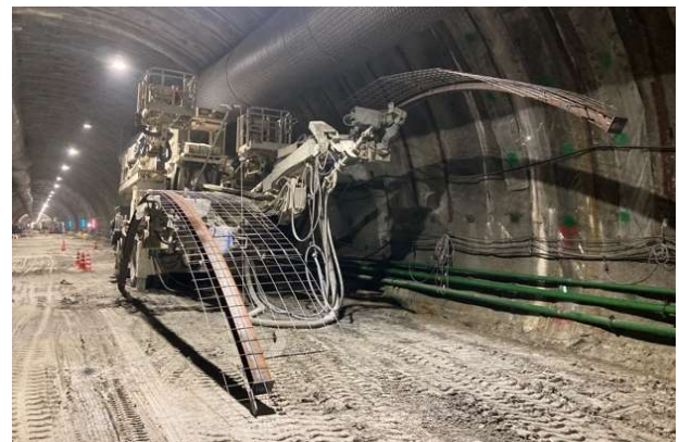
写真-4.3 金網の設置状況
