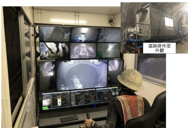
写真－１ 吹付けコンクリートの遠隔施工
