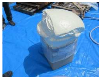
写真－2 UB-WALL工法用ウレタン発泡状況
