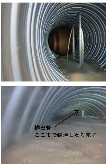
写真-8 無収縮モルタル注入状況
