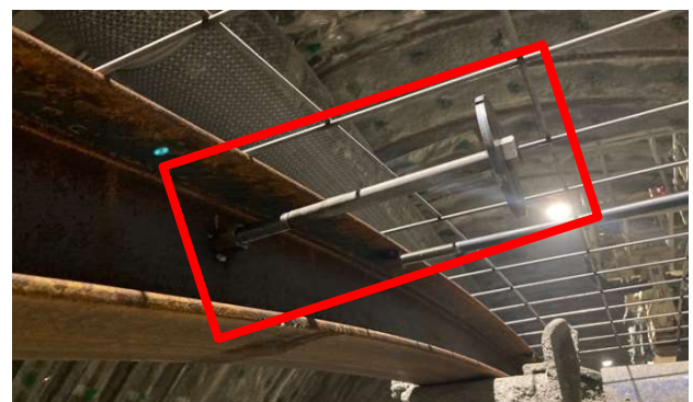
写真-4.4 頭付きアンカーの設置例
