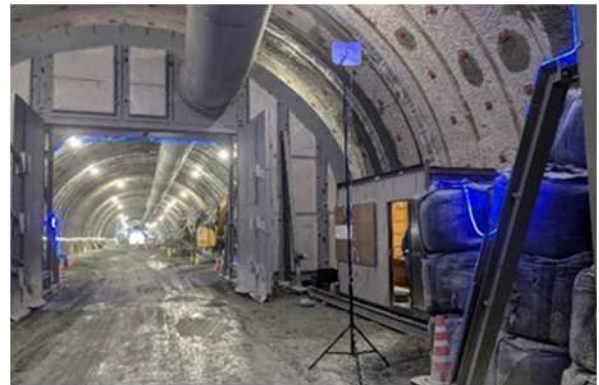
写真-2 屋外長距離通信性アンテナ 配置状況(その 2)
