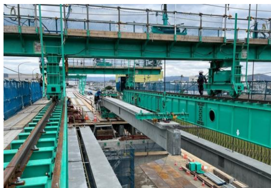
写真－1 桁部材架設状況
