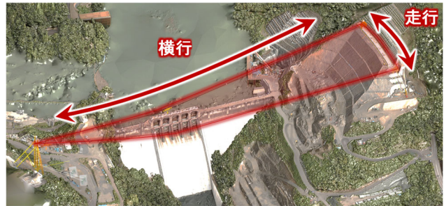
図－２ 新丸山ダムで導入した18t弧動式ケーブルクレーン
